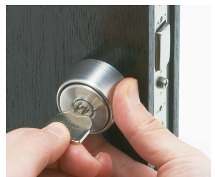
⑥ シリンダーをねじ込むときは一杯まで回し切り、写真のようにMIWAの刻印が上になる位置まで戻してください。この位置が正確でないとシリンダー止めネジが入りません。
