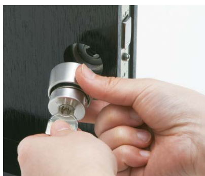
⑤ 回し切るとシリンダーが外れます。 ①～⑤を逆に行くとシリンダーを取り付けることができます。
